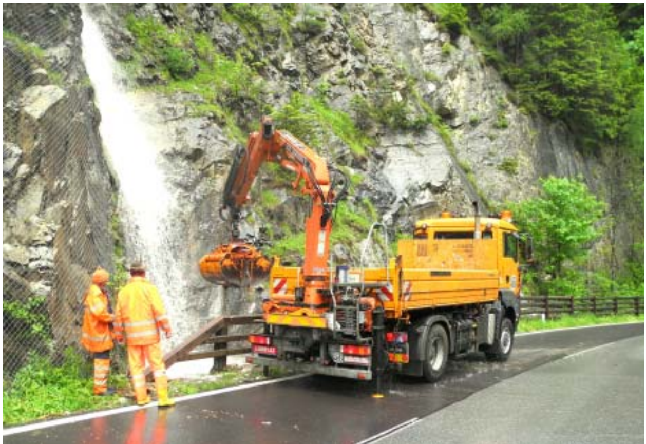
Hochwassereinsatz im Pfarrverband
